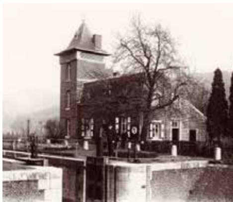
Écluse et maison de la Mâle Èwe. Toujours visible actuellement, cette dernière date d'après la construction du chemin de fer
