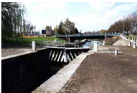
Les portes de l'écluse étaient toujours présentes bien après la disparition du pont-levis
