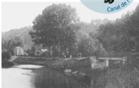
Pont-déversoir et entrée du canal
