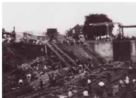
Travaux de maçonnerie des perrés.
