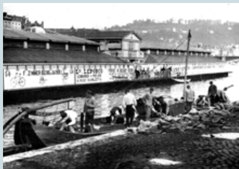
Déchargement de pierres à Liège quai des Pêcheurs (actuel quai Van Beneden).
