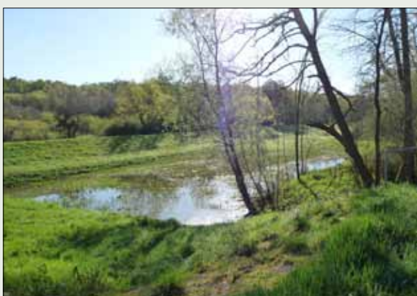
⑤ Bassin d'orage en eau
