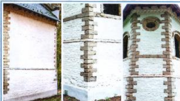
Gordon de pierre en cavet | Chaînage d'angle harpé | Oculus ovale, encadrement des baies sous archivolte, bandeau de pierre, frise dentée au sommet des murs.
