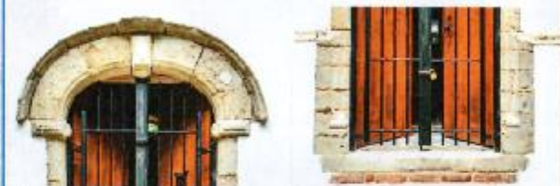
Arc surbaissé du portail, à clé et Piédroits de la porte posés sur des impostes saillantes et sculptées. bases de type gothique tardif.
