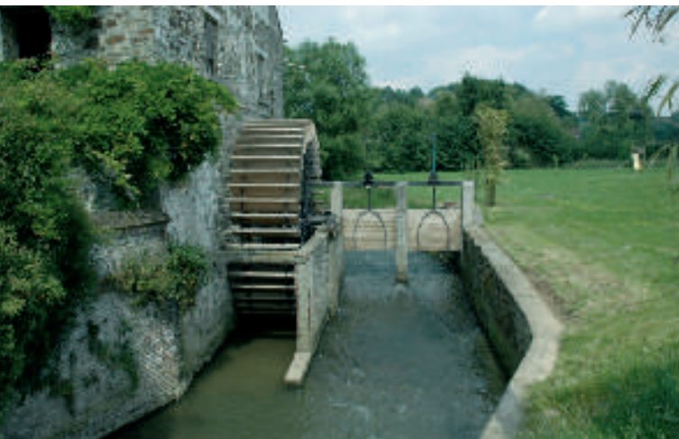
Le moulin de Beurieux, récemment restauré
