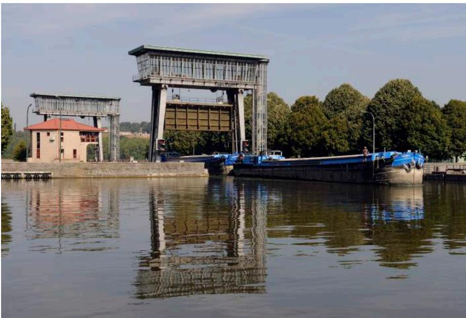
L'écluse d'Iltre est dotée tant en amont qu'en aval de vastes plans d'eau. Ses grands bassins ont pour but d'éviter la propagation des ondes dues au maniement de l'écluse. Grâce à ces plans d'eau, un club nautique a pu être créé. Face à la capitainerie, voici le port de plaisance d'Asquemont.
