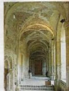
Aile Est du Cloître avec les vestiges du XIIème des bases de la salle Capitulaire
