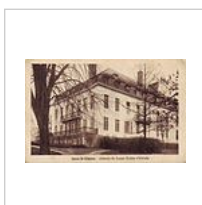
La façade N-O (côté rue des Écoles).
