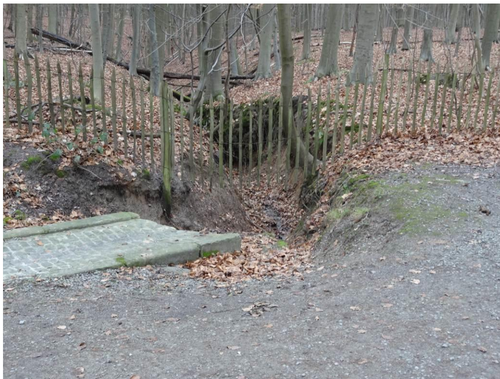
Photo 6.1 – Arrivée des eaux de ruissellement de la voirie communale
